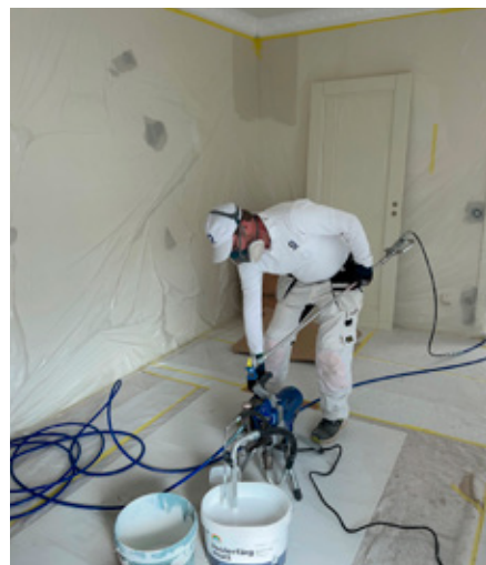
Sprutmålning ger ett rationellt måleri och sparar dessutom på kroppen.
