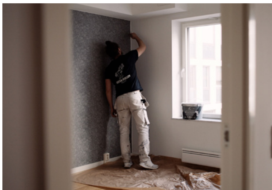
Det är viktigt att vara stolt över sitt hantverkskunnande, menar företagets ägare.
